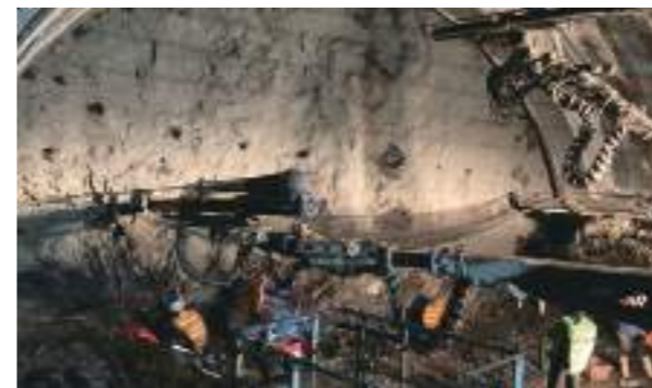
従来の火薬装填・結線状況。コンクリートを吹き付けられた掘削面（切羽）の直下で落石防護ネット等の安全対策を行いながら火薬の装填・結線作業を行う。作業中に地山が崩れるなどの災害に巻き込まれないように、遠隔化が求められる。
