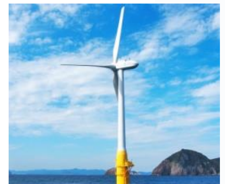
環境省 五島市沖 2.0MW 2015fy実証終了・商用運転に移行
