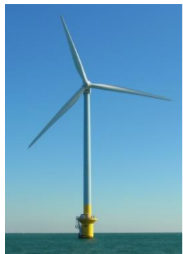
NEDO銚子沖 2.4MW 2016fy実証終了 商用運転に移行
