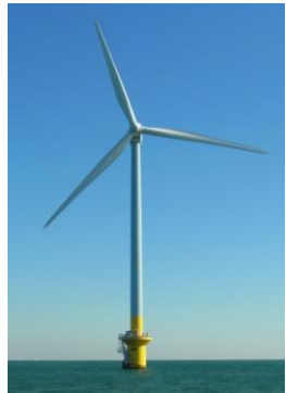
NEDO銚子沖 2.4MW 2016fy実証終了 商用運転に移行
