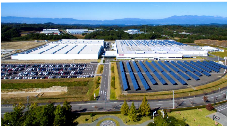
上：デンソー福島工場に設置した水電解装置 下：デンソー福島工場全景（太陽光発電の電力にて水素製造）
