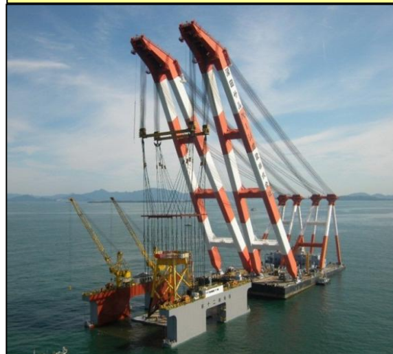
支持構造物 玉掛状況
