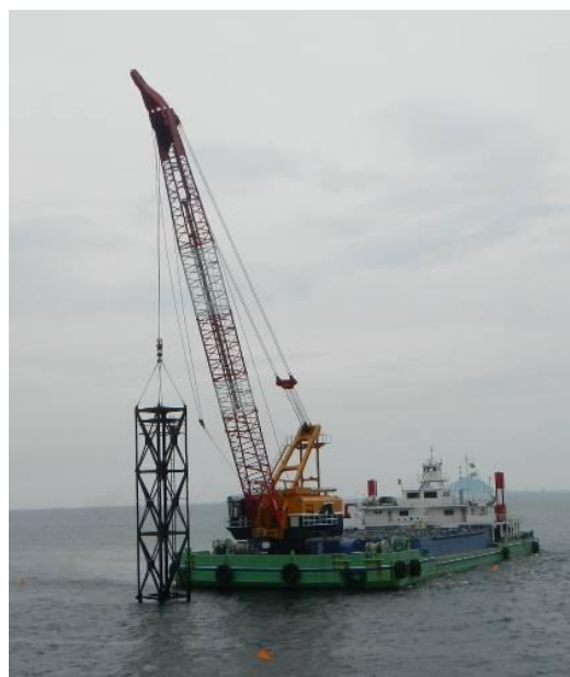
基礎部の重錘均し状況
