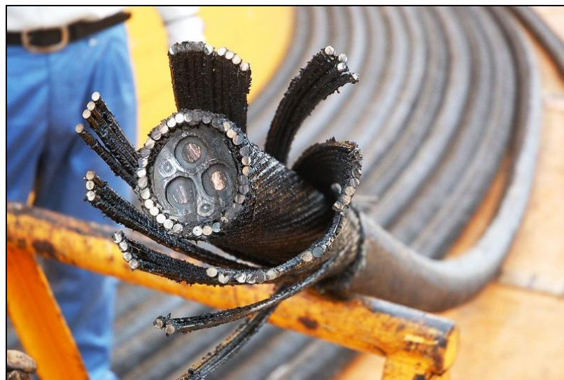
海底ケーブル端末処理状況
