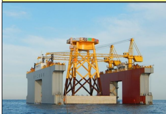
支持構造物 係留状況
