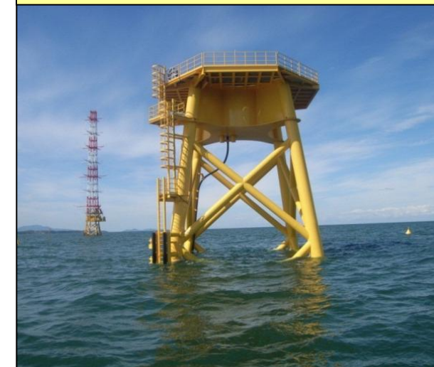
支持構造物設置完了
