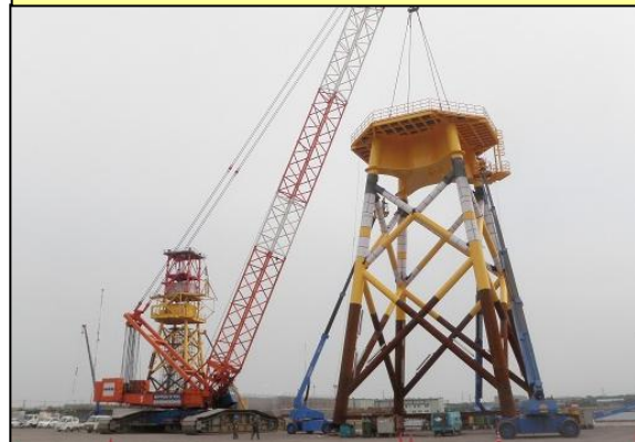
支持構造物 ジャケット製作状況
