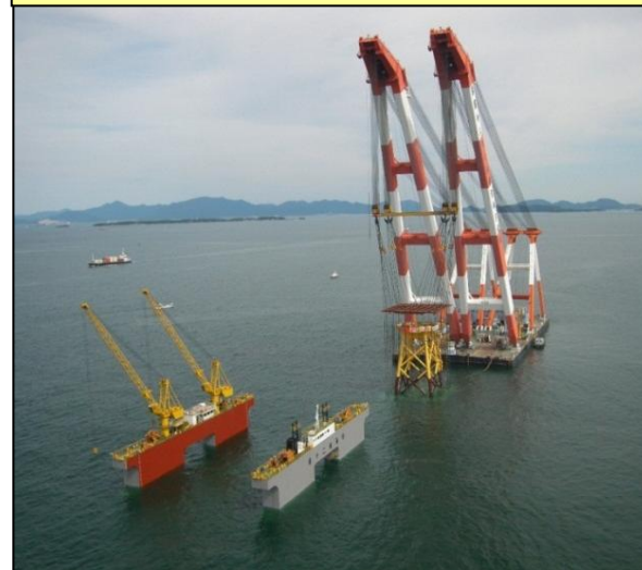
FD2次注水、位置合わせ状況
