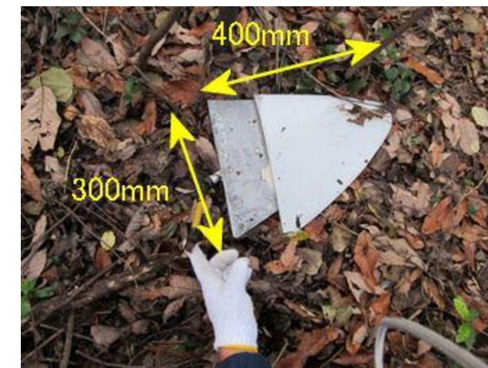
図 4 レセプタ脱落状況
