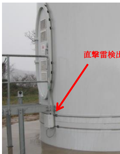
図-1 直撃雷検出装置
