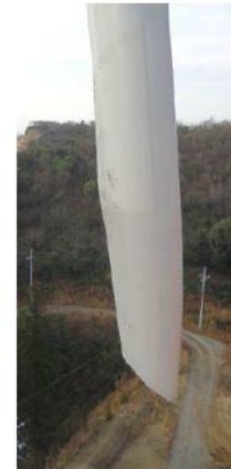
ブレードの損傷
