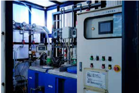
写真6 施設内のクロラミンの合成施設。分解しやすいため次亜塩素酸ナトリウムとアンモニアを施設内で混ぜてつくる
