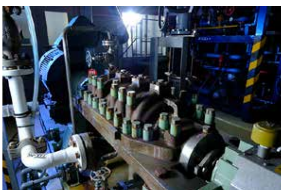
写真5 下水 RO 濃縮水で希釈された海水を RO 膜へ送り込むポンプ
