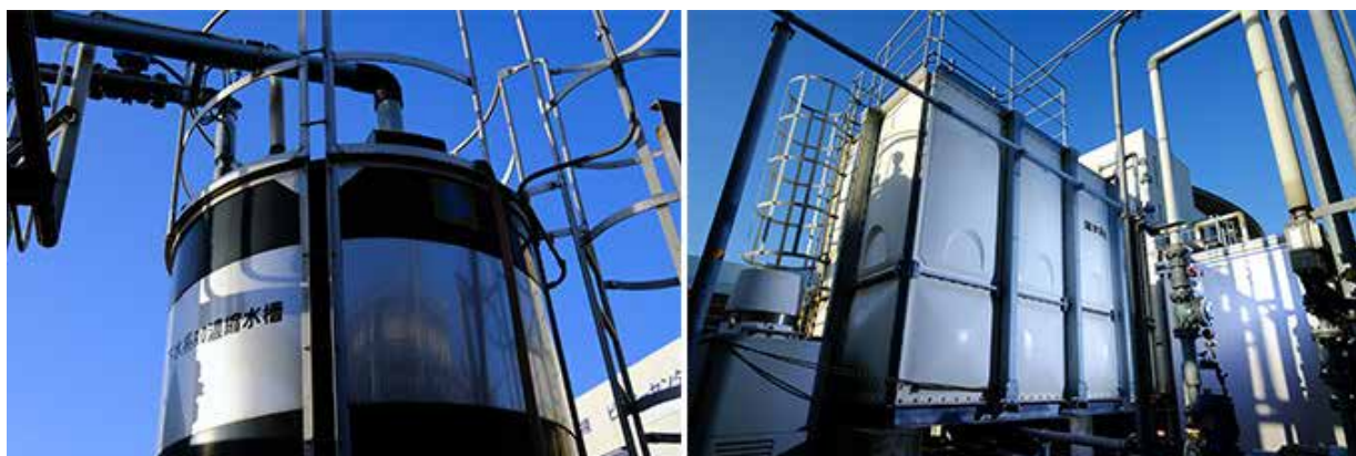
写真3 下水を処理した後(左)、その過程で生じた排水(下水RO濃縮水)を海水淡水化の工程(右)に送り込む
