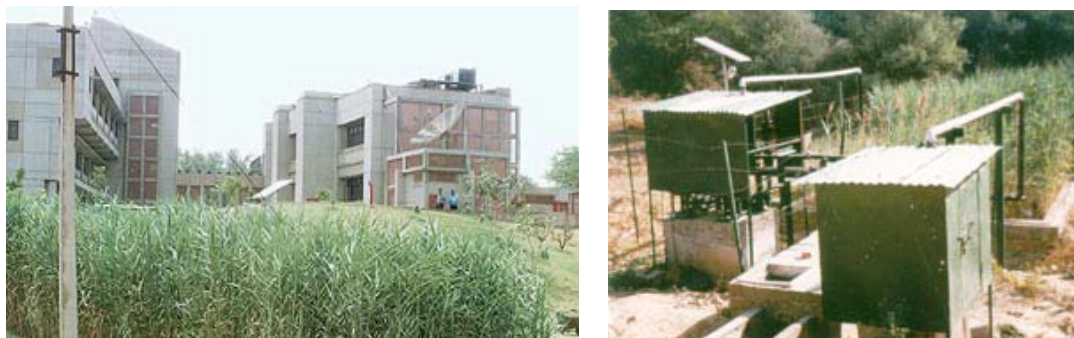
生物フィルタとして機能する廃水処理用のアシの苗床
