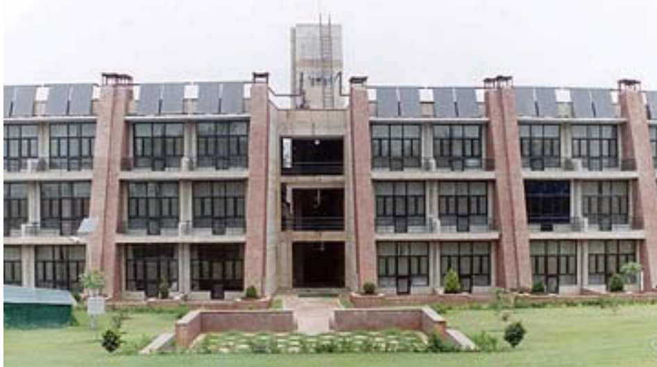
RETREAT の南側：太陽熱温水器とソーラーchimneyが設置されているのが見える
