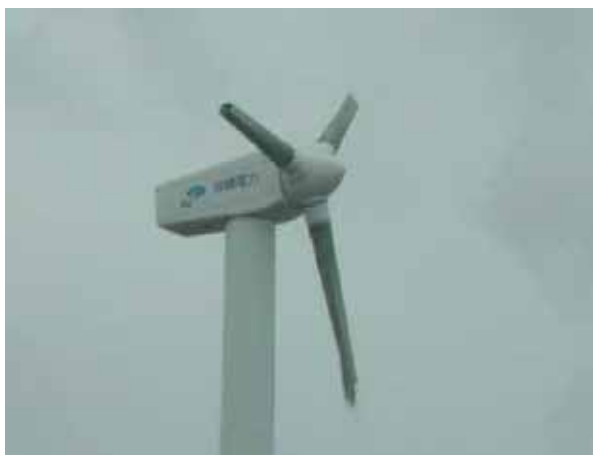
図 3.1 台風 0314 号によるブレード被害
