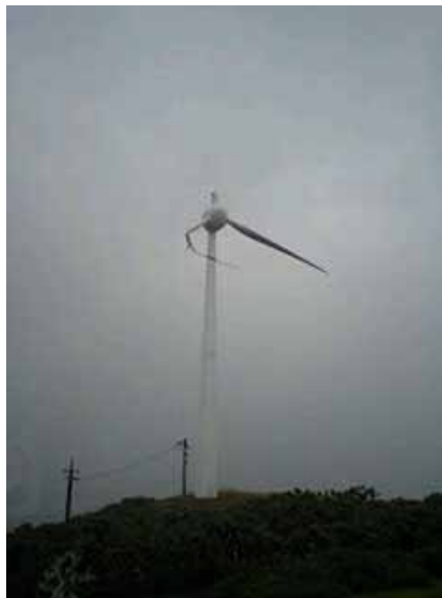
図 3.2 台風 0715 号によるブレード被害
