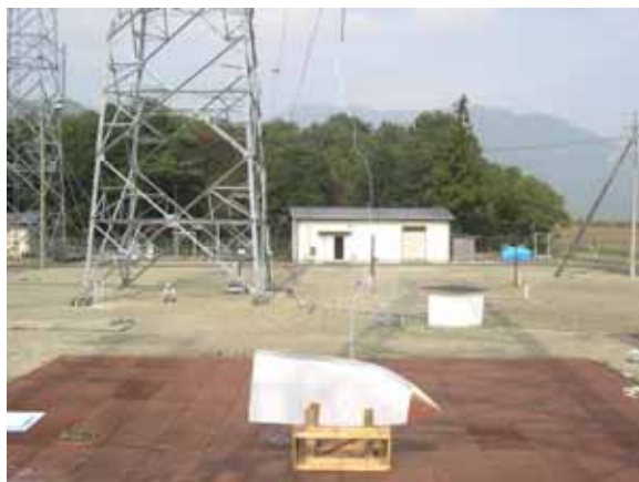
図C1.8 先端金属ブレードへの放電状況の例（正極性、汚損なし）
