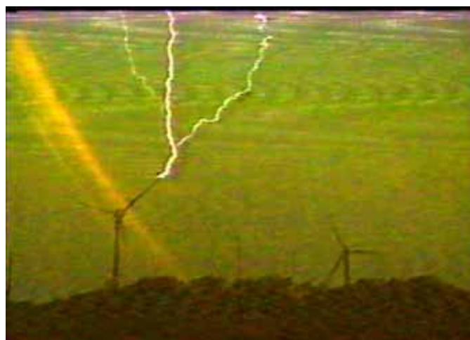
図D.2 ブレードへの雷撃例2
