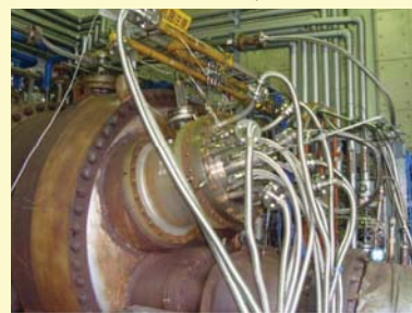
高圧試験装置
