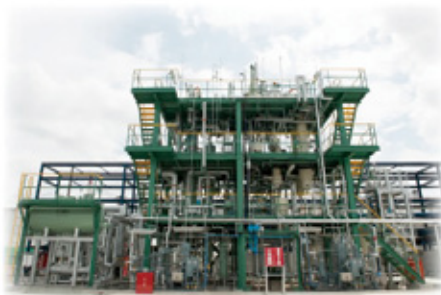
■デモプラント 装置性能：50 Nm 3 /h の水素貯蔵と水素発生
