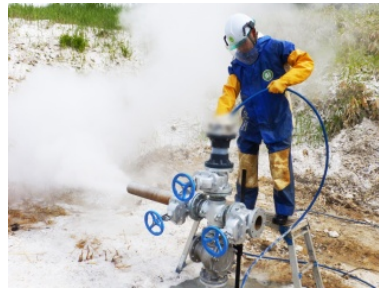
図IV(4.6)-1 抗井内噴気状況でのジェット洗浄実証実験状況
