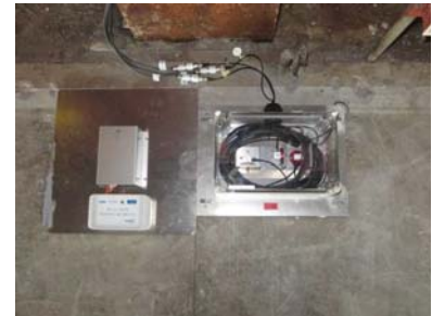
20階 加速度センサ設置状況
