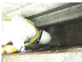
図2 桁端部の狭隘空間と点検障害物
