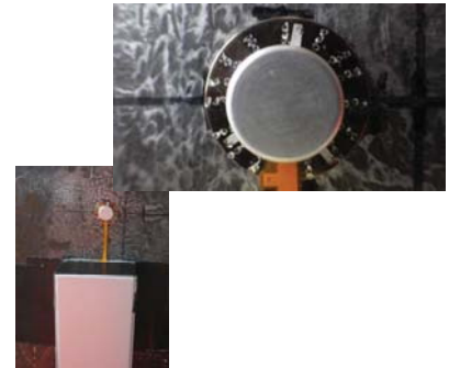
5階 ひずみセンサ設置状況
