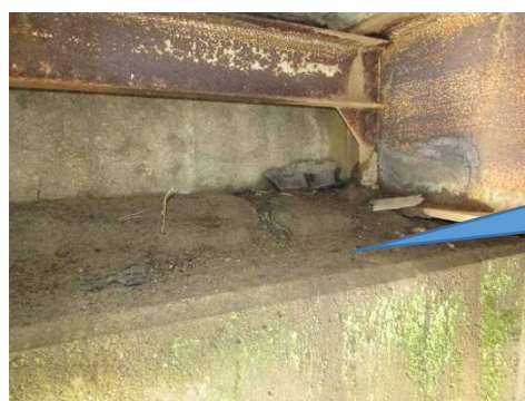
図Ⅲ-【③-(1)-4】- 5 支承周辺の土砂堆積による点検障害
