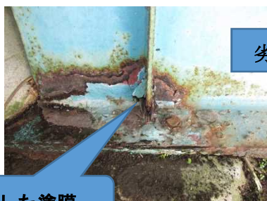
図Ⅲ-【③-(1)-4】- 6 鋼製主桁の劣化した塗膜除去による点検状況
