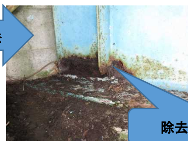
図Ⅲ-【③-(1)-4】- 6 鋼製主桁の劣化した塗膜除去による点検状況
