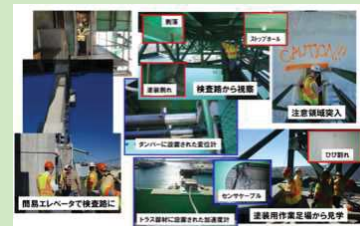
写真6 Vincent Thomas機械室からの調査の様子
