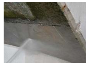
高圧噴射実験（実橋）
