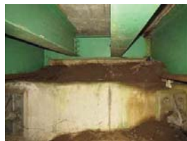
図2 桁端部の狭隘空間と点検障害物
