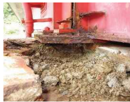
下部工 橋座土砂化
