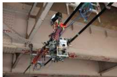
写真：橋梁ロボット移動状況
