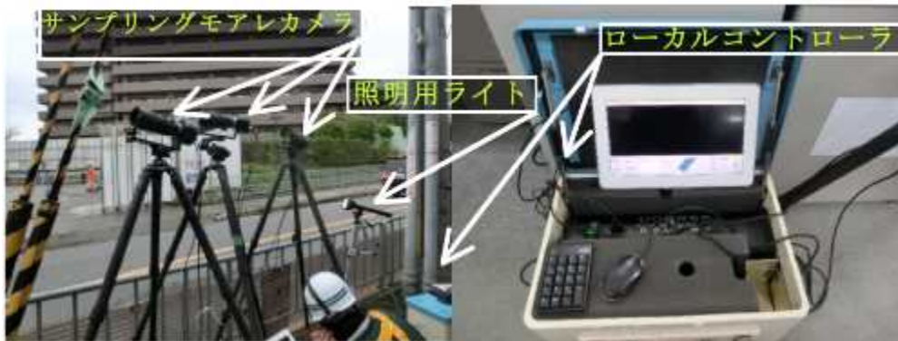
図Ⅲ-【②-2】-13 夜間対応の同期計測システム
