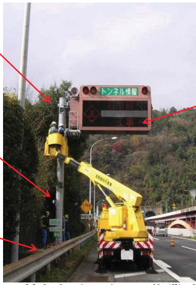
情報板全景(設置作業時)
