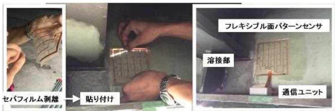
図Ⅲ-【①-1】-12 鋼橋へのフレキシブル面パターンセンサの施工
