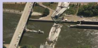
米国ミネソタ州ミネアポリス ミシシッピ川に架かる高速道路橋の崩落
