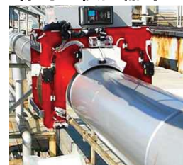
化学プラント現場での 動作検証試験
