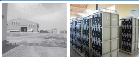
2.7MW/6.9MWh 鉛電池システム/新神戸電機 再エネ電源の出力安定化(風の王国) 「平成24年度 再生可能エネルギー導入のための蓄電池制御等実証モデル事業」
