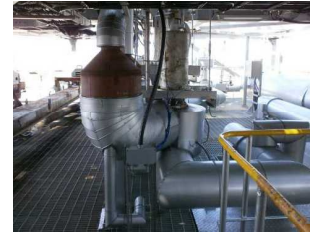
実缶試験 弁据付 熱電対取付け
