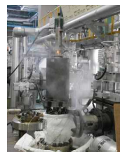
動作(吹出し)試験
