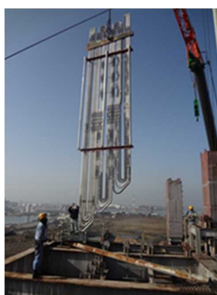
図 43 700°C級過熱器 (ボイラへの組込み)
