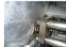
グランドパッキンシール状況確認 9
