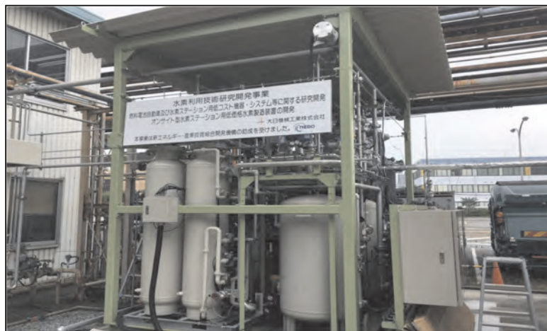
図 15 現地据付状態
