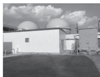
(b) 水素製造設備
