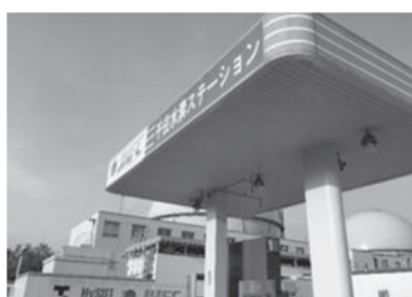
(a) 供給設備建屋
