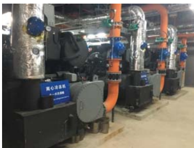
INVターボ冷凍機(三菱重工) 1500kW(426USRT)×3台
