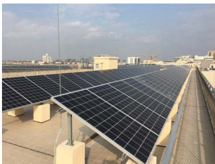
太陽光発電パネル 85kw (京セラ) (270W × 315枚)
