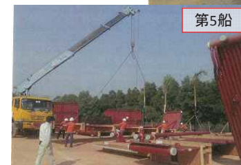
ボイラ 現地荷降ろし状況
