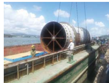
第1船 Cai Lan水切り状況
