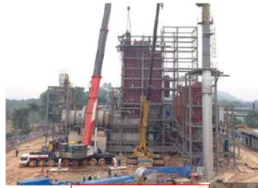
機器据付状況
