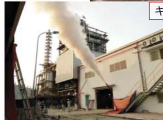
蒸気フラッシング
