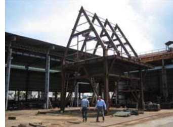
第三国調達機器の仮組み検査
