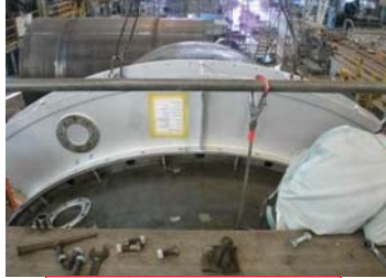
堺工場での仮組み立て
