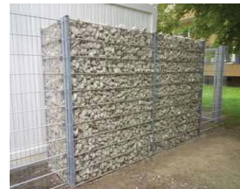
室外機の室内設置および遮音壁設置
