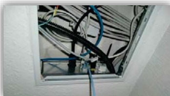
居住宅天井点検口
