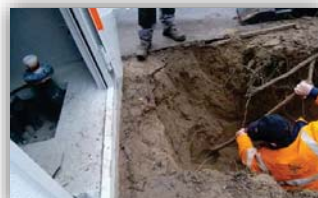
地中埋設配線工事
