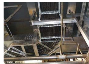
電気計装・工事状況
