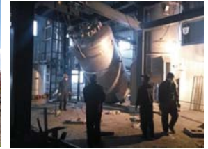
機器据付工事状況
