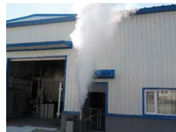
配管蒸気フラッシング
