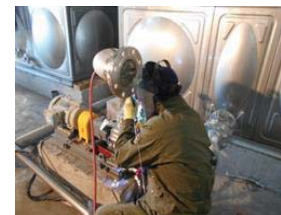
配管工事状況
