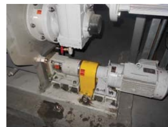
原料移送ポンプの単体試運転
