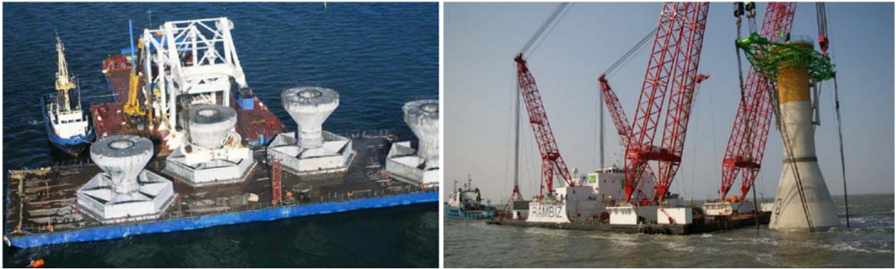
図Ⅲ.6.2-23 重力式構造物のバージ（左図:Lindvig, 2009）と起重機船（右図:Lindvig, 2011）による運搬
