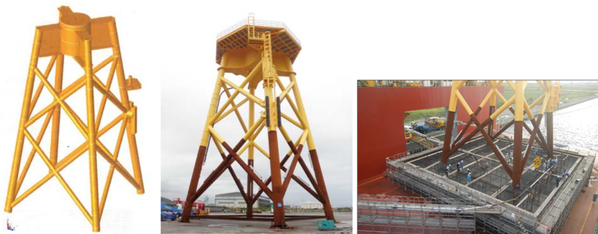
図Ⅲ.4.4-6 北九州市沖サイトにおけるハイブリッド重力式支持構造 右図は底板コンクリートの打設状況
