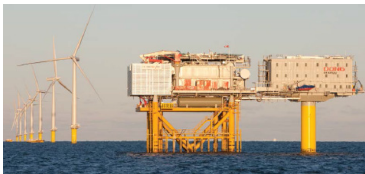
図Ⅲ.7.3-12 Horns Rev2における固定式宿泊施設 (GL Garrad Hassan, 2013)
