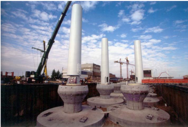
図Ⅲ.6.2-21 重力式構造物のドライドックにおける製造（Copenhagen Environment and Energy Office, 2003） Middelgrunden
