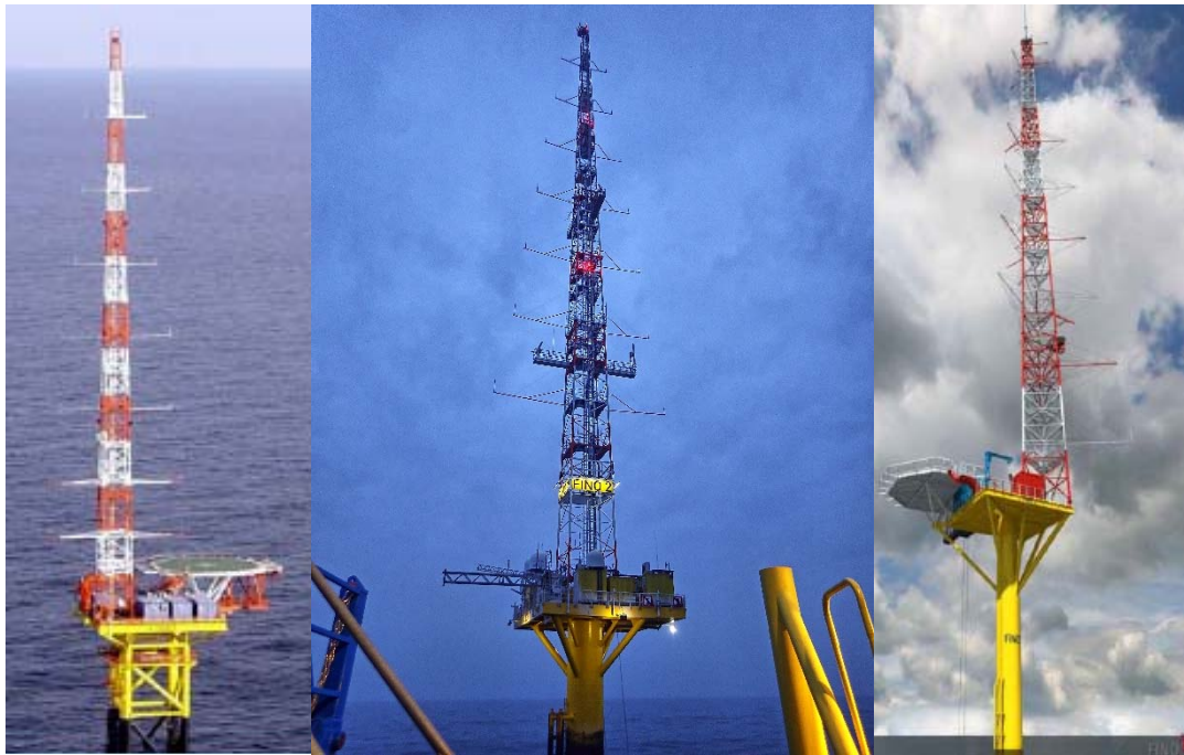
図Ⅲ.3.1-6 FINO1 (左), FINO2 (中) および FINO3 (右) の外観図 左右 : Kellner (2008) 中 : DNV GL 提供
