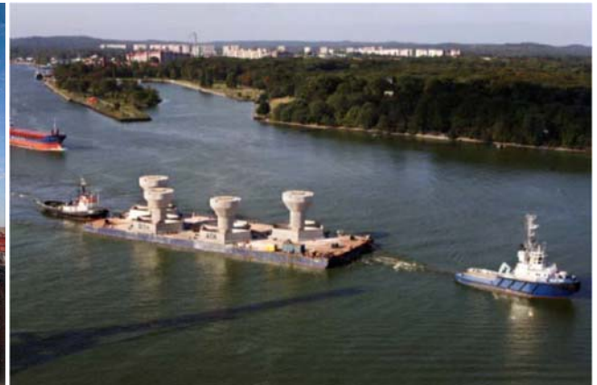
図Ⅲ.6.2-22 重力式構造物のポンツーン上における製造と運搬（Vattenfall, 2008） Lillgrund
