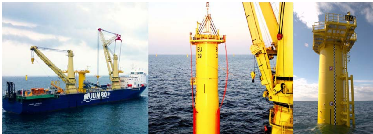
図Ⅲ.6.2-13 トランジションピースの運搬と設置
