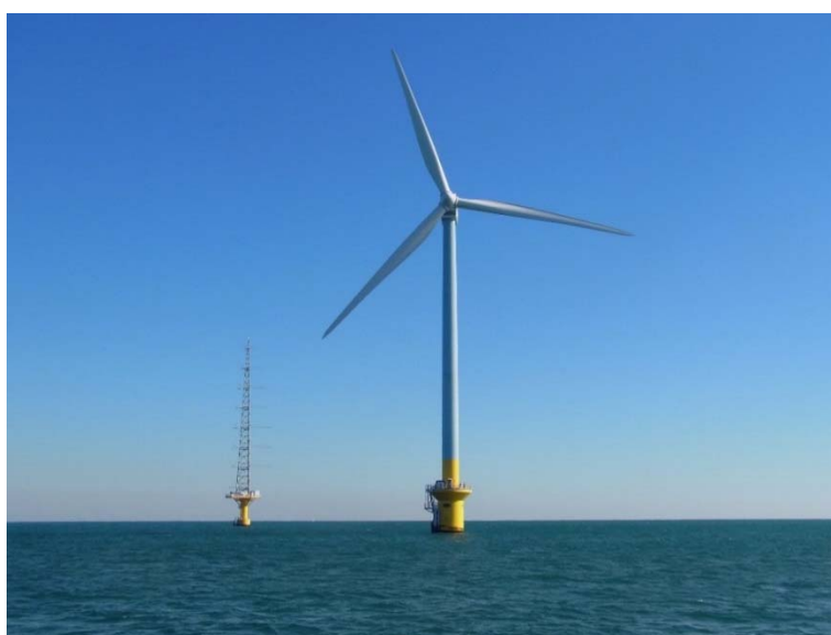
図Ⅱ.3.2-5 着床式洋上風力発電実証研究施設（銚子沖）
