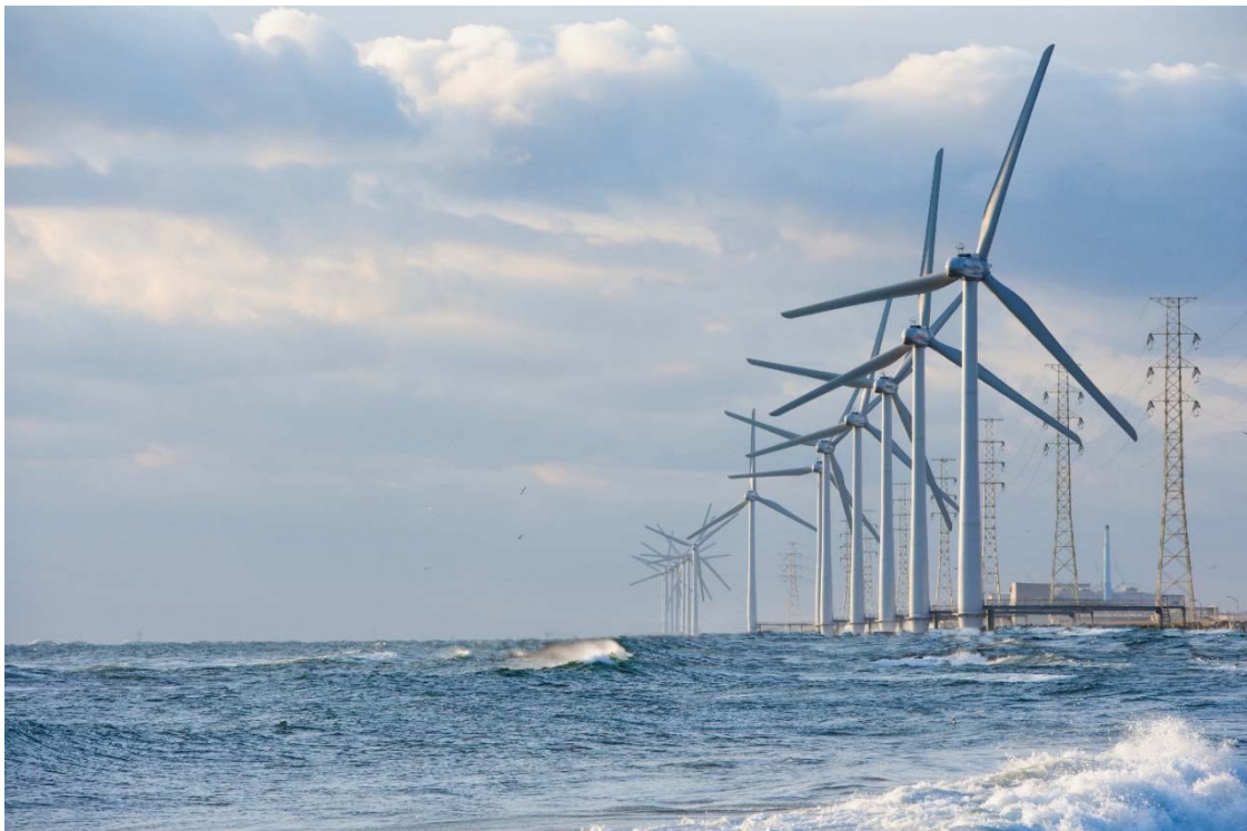
図Ⅲ. 6. 2-46 ウィンド・パワーかみす第2洋上風力発電所の完成時の状況 (ウィンド・パワー資料： http://www.komatsuzaki.co.jp/windpower/kamisu2.php )
