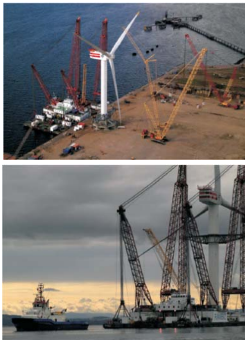
図Ⅲ.6.2-43 Beatrice における風車の設置工事 sse HP : http://sse.com/media/113127/AllBoards2010.pdf
