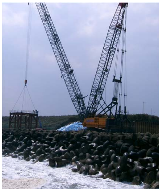
図Ⅲ.6.2-10 陸上から作業中のクローラクレーン (岡野, 2010)
