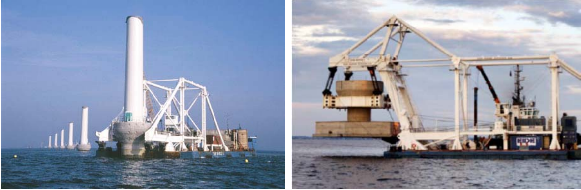
図Ⅲ.6.2-25 フローティングクレーンによる重力式支持構造物の据付
