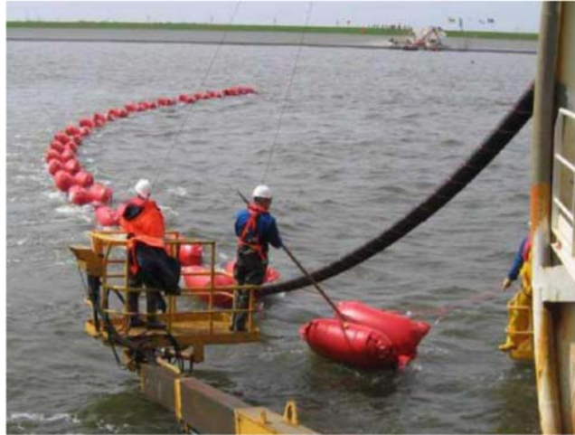
図Ⅲ. 6. 2-59 沿岸部における海底ケーブル敷設状況（日本産業機械工業会, 2010）
