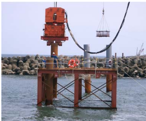
図Ⅲ.6.2-11 導杭打設状況（岡野, 2010）
