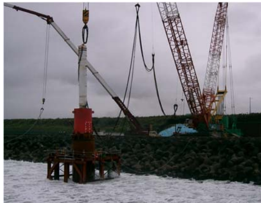
図Ⅲ.6.2-12 モノパイル打設状況（岡野, 2010）
