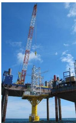
図 11 銚子沖 洋上風況観測タワーの建設状況
