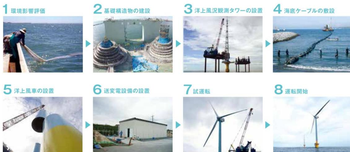
図 10 銚子沖洋上風力発電所の作業工程
