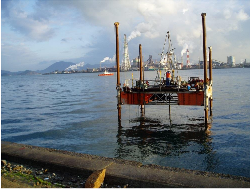
図Ⅲ. 3. 3-3 ボーリング調査の例 (大和探査技術提供)
