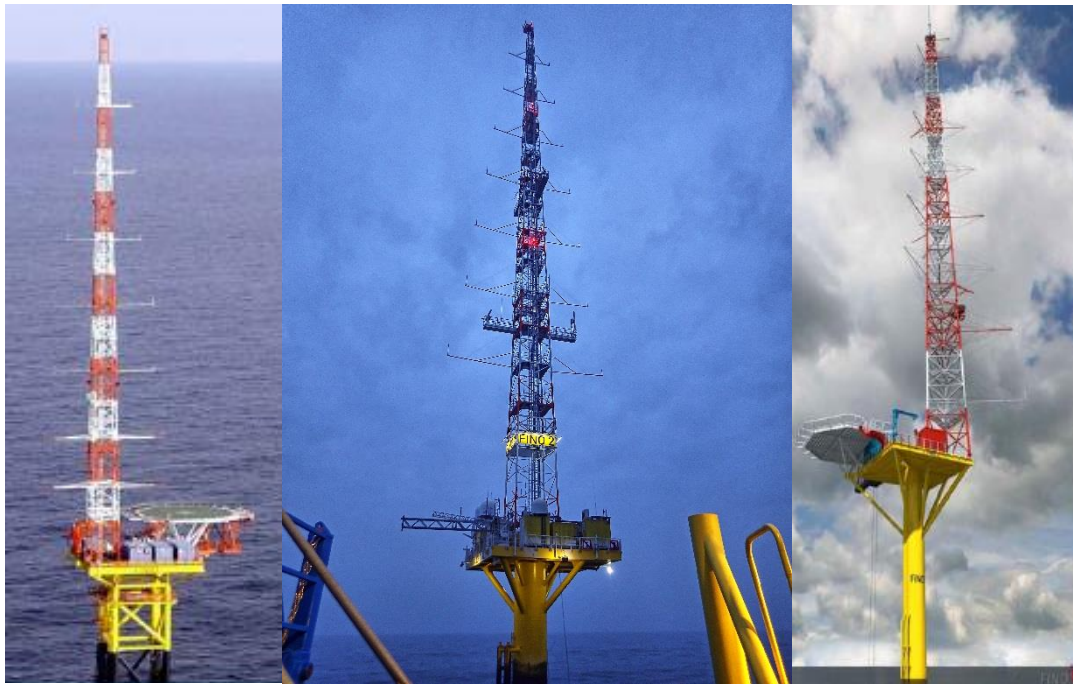
図Ⅲ.3.1-6 FINO1 (左) ,FINO2 (中) およびFINO3 (右) の外観図 左右 : Kellner (2008) 中 : DNV GL 提供
