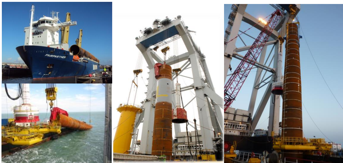
図Ⅲ.6.2-6 モノパイルの運搬状況（Ballast Nedam, 2011）
