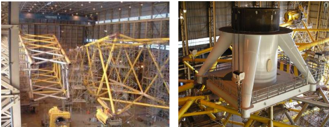
図Ⅲ.6.2-30 ジャケット（左図）とトランジションピース（右図）の製作状況 (Robertson, 2008)
