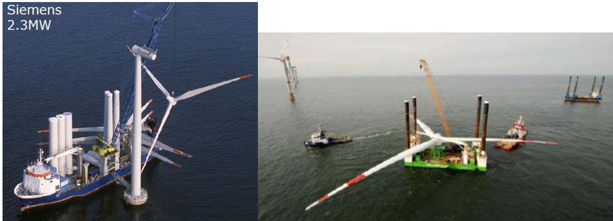
図Ⅲ. 6. 2-40 風車（左図 Siemens2. 3MW/右図 REpower5. 0MW）のナセル設置工事 (Lindvig, 2011)
