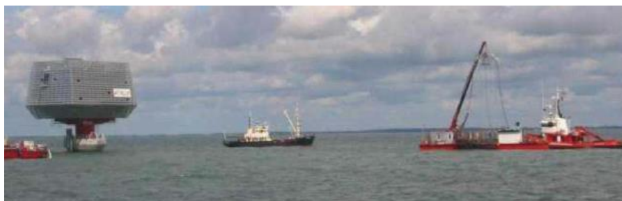
図Ⅲ. 6. 2-61 海底ケーブルの敷設状況（日本産業機械工業会, 2010）
