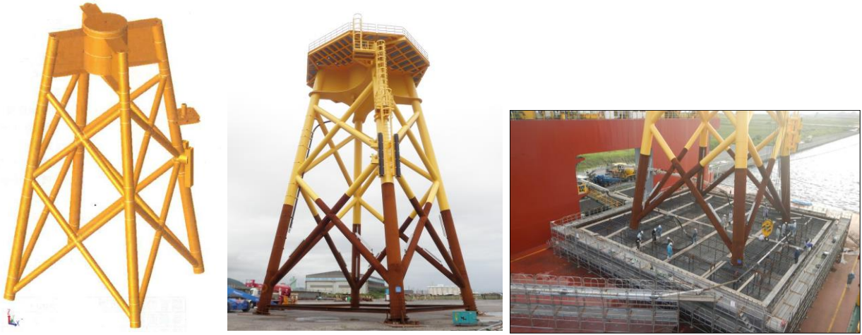
図Ⅲ.4.4-6 北九州市沖サイトにおけるハイブリッド重力式支持構造物 右図は底板コンクリートの打設状況
