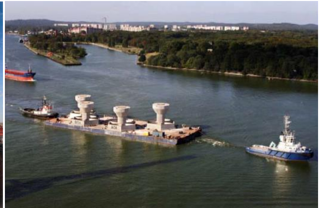
図Ⅲ.6.2-22 重力式構造物のポンツーン上における製造と運搬（Vattenfall, 2008） Lillgrund
