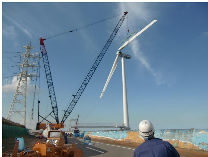
上左図：モノパイルへのボルトタワーの接続 上右図：ナセルへのハブの据付 下中央図：ブレードの据付
