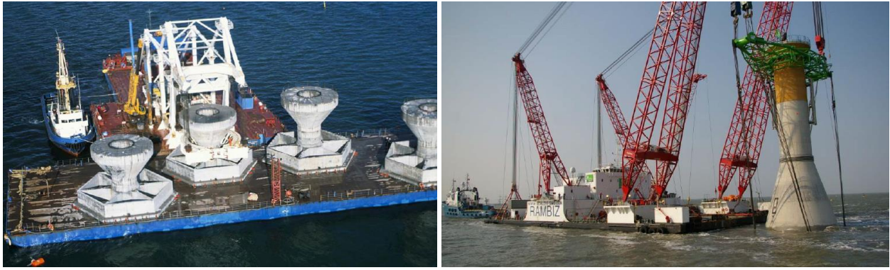
図Ⅲ. 6. 2-23 重力式構造物のバージ（左図:Lindvig, 2009）と起重機船（右図:Lindvig, 2011）による運搬
