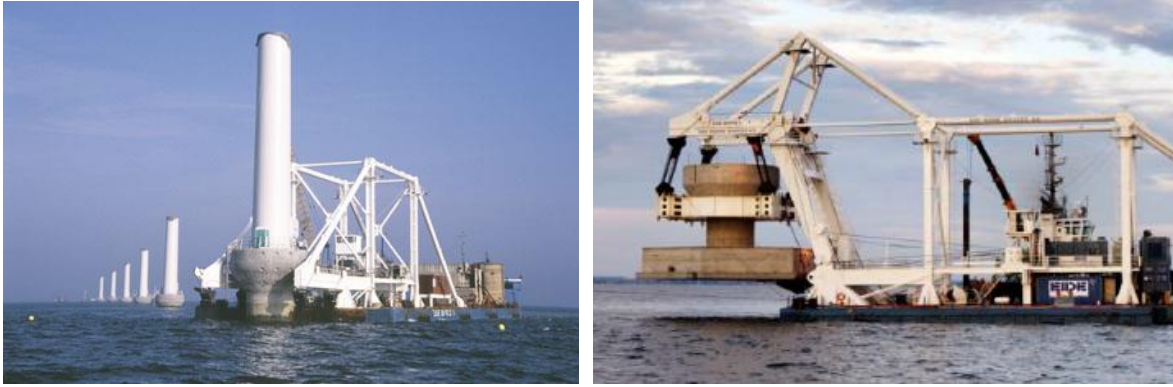
図Ⅲ.6.2-25 フローティングクレーンによる重力式支持構造物の据付
