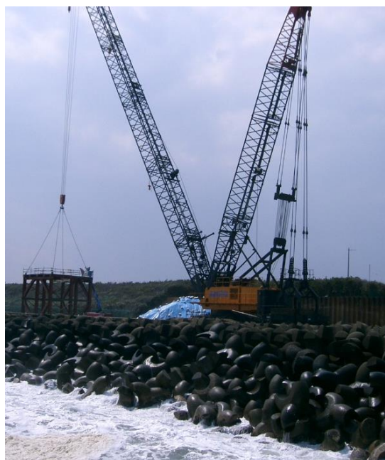
図Ⅲ.6.2-10 陸上から作業中のクローラクレーン (岡野, 2010)
