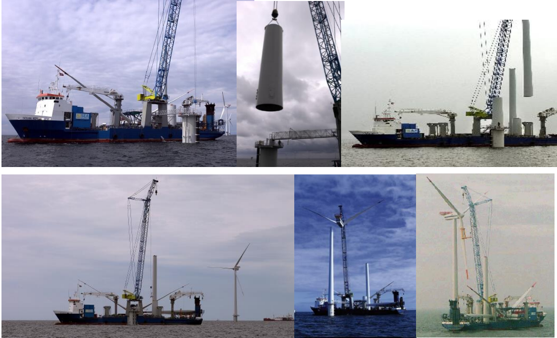
図Ⅲ. 6. 2-36 Horns Rev における風車の設置工事 (Japan Ocean Development Construction Association, 2002; 下右図のみ Garrad Hassan, 2009)
