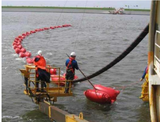
図Ⅲ. 6. 2-59 沿岸部における海底ケーブル敷設状況（日本産業機械工業会, 2010）
