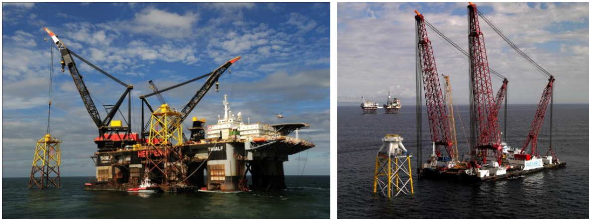
図Ⅲ.6.2-32 ジャケットの吊り上げ（左図：Ballast Nedum, 2011）と据付（右図：Robertson, 2008）状況
