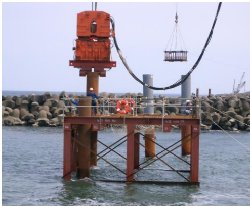
図Ⅲ.6.2-11 導杭打設状況（岡野, 2010）
