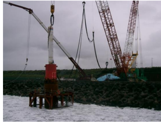
図Ⅲ.6.2-12 モノパイル打設状況（岡野, 2010）
