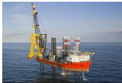
図 2 Borkum Riffgrund1 のサクシオン支持構造物形式 (Weston, 2014)
