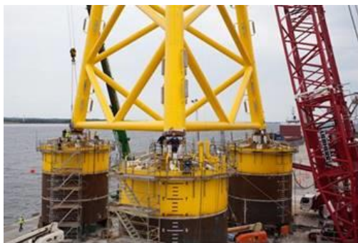
図 2 Borkum Riffgrund1 のサクシオン支持構造物形式 (Weston, 2014)
