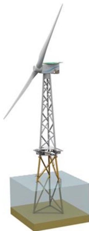
図-5 2B6 の 2 枚翼風車（6.0MW 機）
