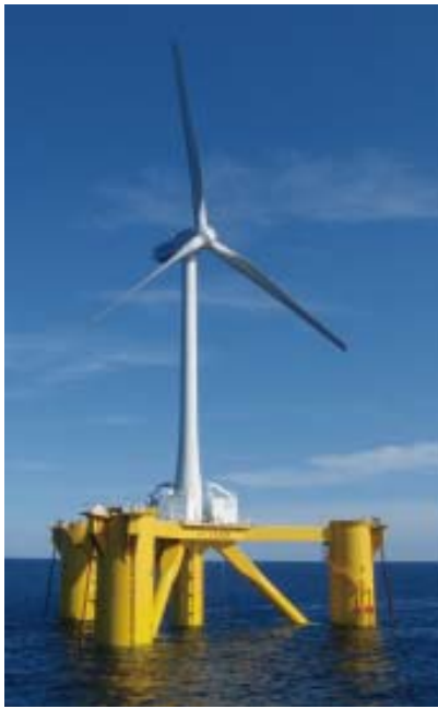
図 3.2-6 セミサブ形式（フーティング型）の例 13
