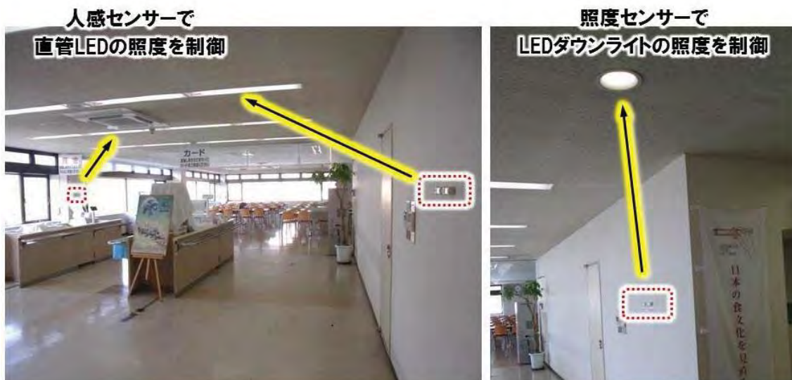
図 1.2.2.4-2 無線センサーと照明の配置.
