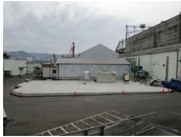
主要機器据付前 敷地全景
