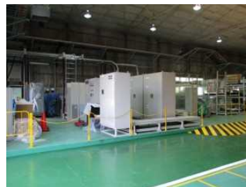
屋内設備設置状況
