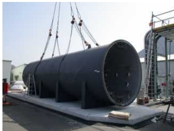
圧力容器搬入
