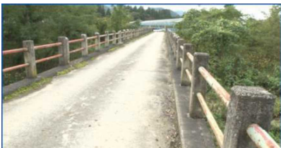
老朽橋梁の点検
