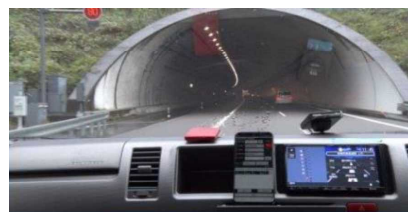
三岳山トンネル(新東名高速道路)
