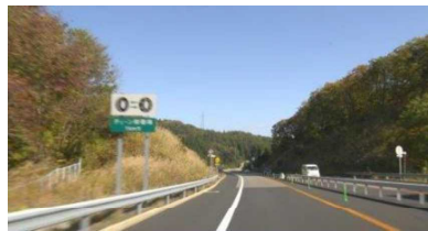
要注意法面の監視
