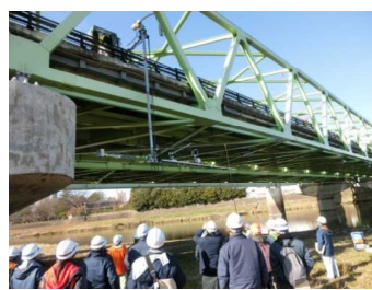
実証実験への 点検関係者の招待 2016年12月22日
