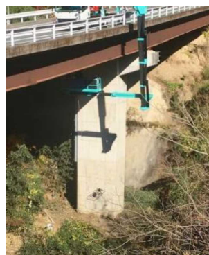
橋梁点検車とドローンの連携運用
