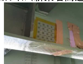
高架橋(阪神高速道路管内)
