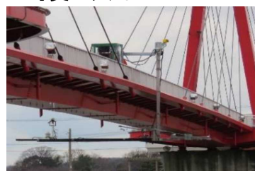
アーム型点検ロボット
