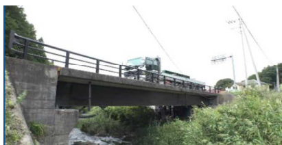
道路橋梁(郡山市)
