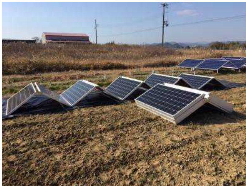
図Ⅲ-2-①-(3)-10 開発した折りたたみ架台
