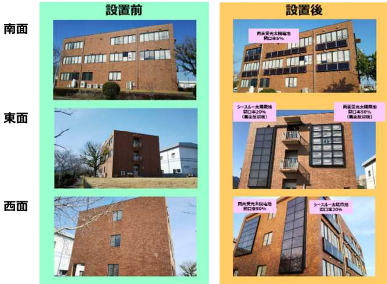
図Ⅲ-2-①-(8)-9 機器分析センターのPV設置前およびPV設置後の各方位の写真
