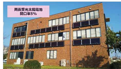
設置費は窓面24%、壁面27%削減 実発電量はPR値で 最大30%向上
