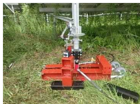
図III-2-④-(3)-7 引抜載荷試験状況(既設杭)
