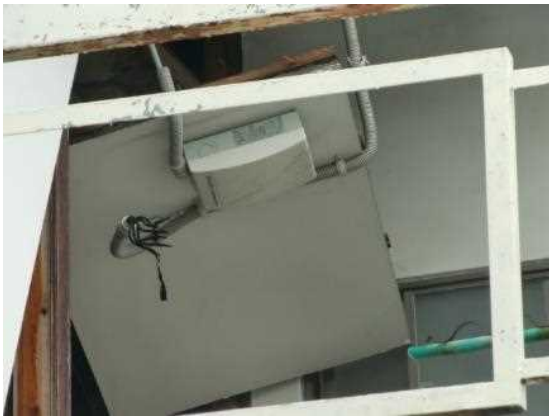
図Ⅲ-2-④-(4)-18 (左) 接続箱の配線は処理されていた (右) PV-Net にて処置を実施
