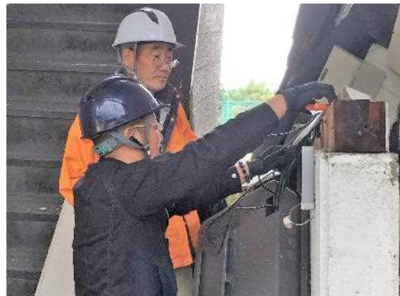
図Ⅲ-2-④-(4)-18 (左) 接続箱の配線は処理されていた (右) PV-Net にて処置を実施
