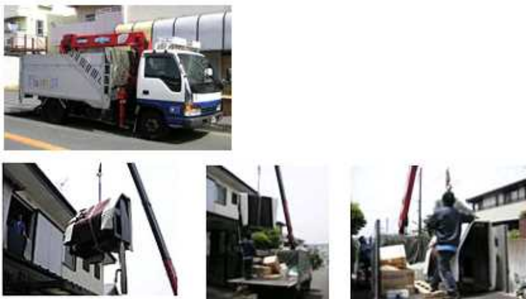
図Ⅲ-2-①-(2)-3 専用ユニック車を用いた荷おろしの様子
