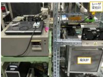
図 3-5-6.15 レーザー変位計の外観
