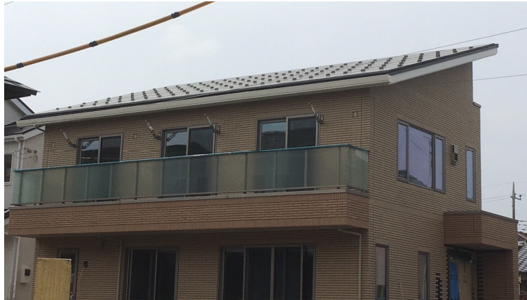
図 2-48 埼玉県の 10 kW ルーフトップ PV の写真(提供：東京大学)
