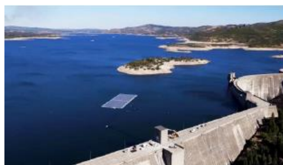
世界初の水力発電・水上PVのハイブリッドシステム (PV=220kW、ポルトガル・Alto Rabagaoダム)
