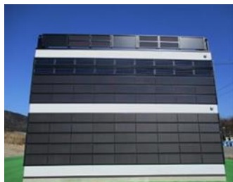
壁面に太陽光パネルを 設置した例
