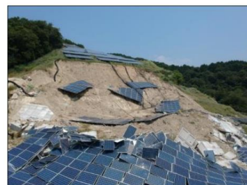
(集中豪雨による土砂崩れ)
