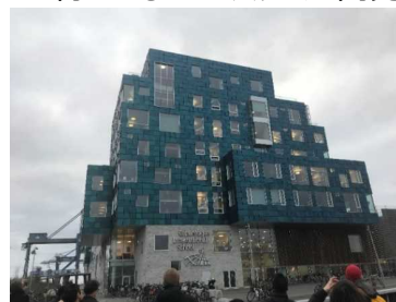
イメージ：既設建築物への太陽光発電設置例(コペンハーゲン)
