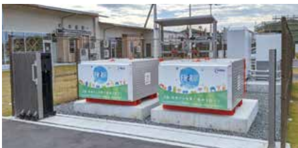
道の駅なみえへ提供している燃料電池。公共施設では、定置用燃料電池で水素を使って発電し、電力や熱が施設内で活用されます。
