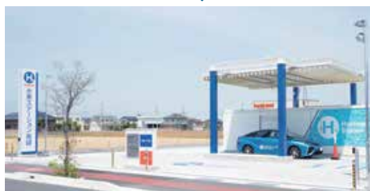
水素ステーションでは、燃料電池車 (FCV) や燃料電池バスへ充填し電力として使用されます。 出典:岩谷産業株式会社
