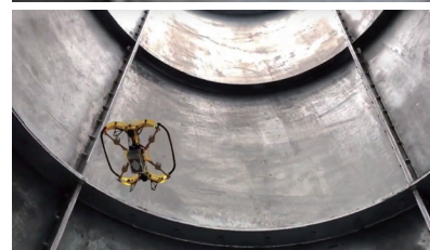
煙突点検の様子
