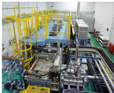
連続焼結設備
