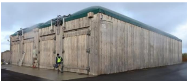
図 2.4.4 乾式メタン発酵バッチシステムの発酵槽（農協組合法人レ・オート・マレットバイオガスプラント）（左）
