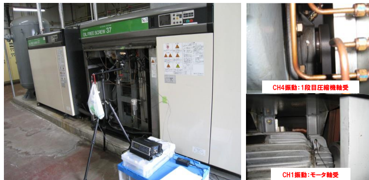
図 3-3.1.3-7 実食品工場内コンプレッサ測定
