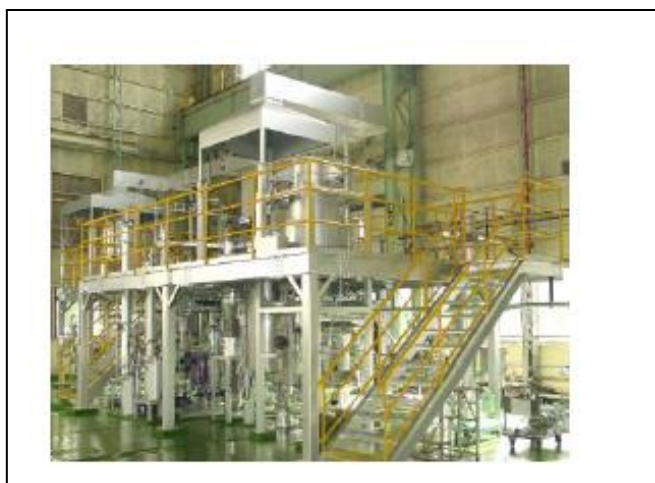
図 1-2-3-1. バイオマスガス化試験設備
