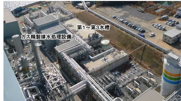
図 3-13 排水処理設備
