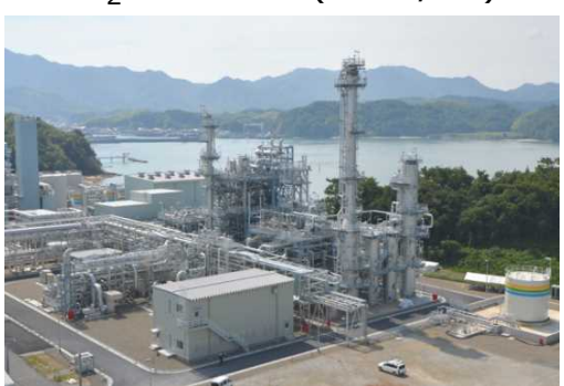
据付工事完了(2019/08)
