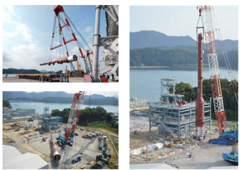
CO 2 吸収塔据付(2018/10)
