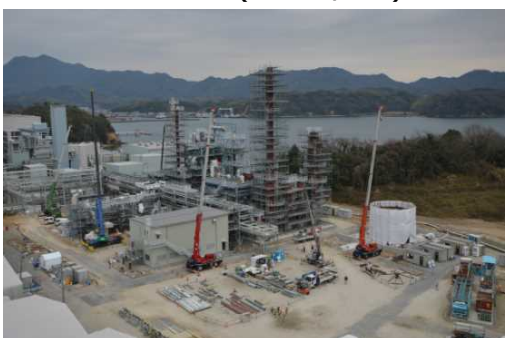
吸収液タンク他据付(2019/02)
