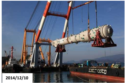
ガス化炉搬入
