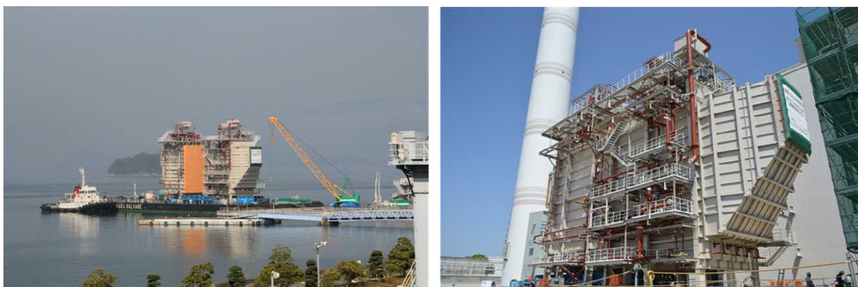
図 3-17 排熱回収ボイラ搬入・据付状況
