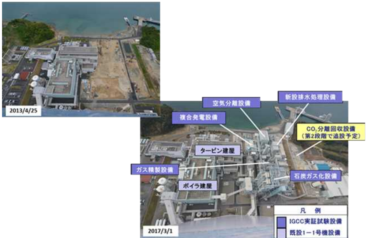
図3-19 設備全体写真（煙突より）
