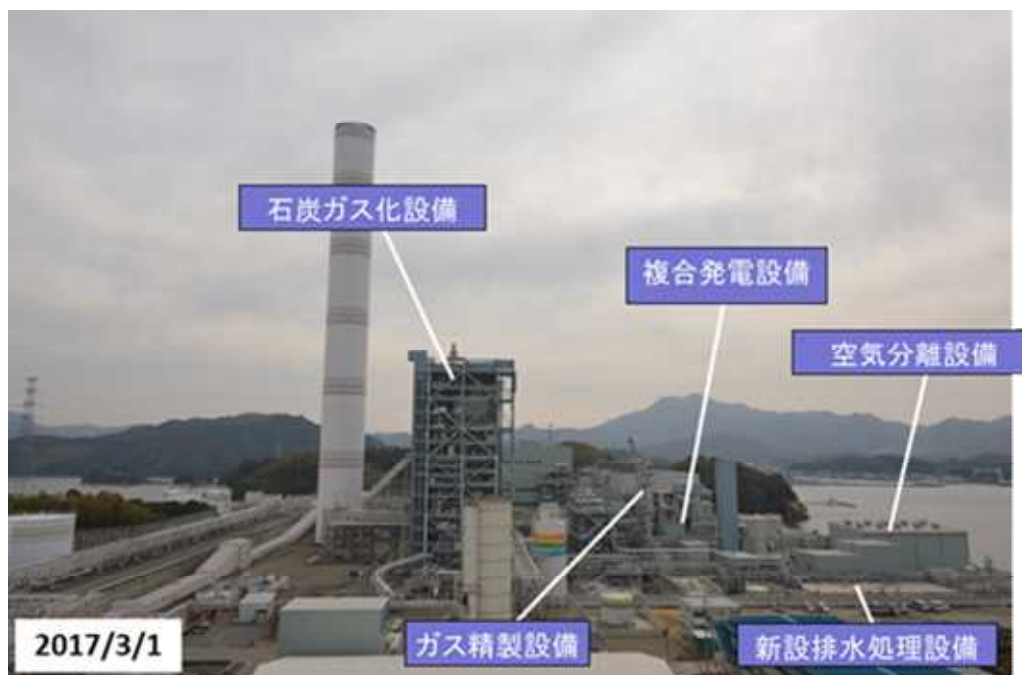
図3-20 設備全体写真（西側より）
