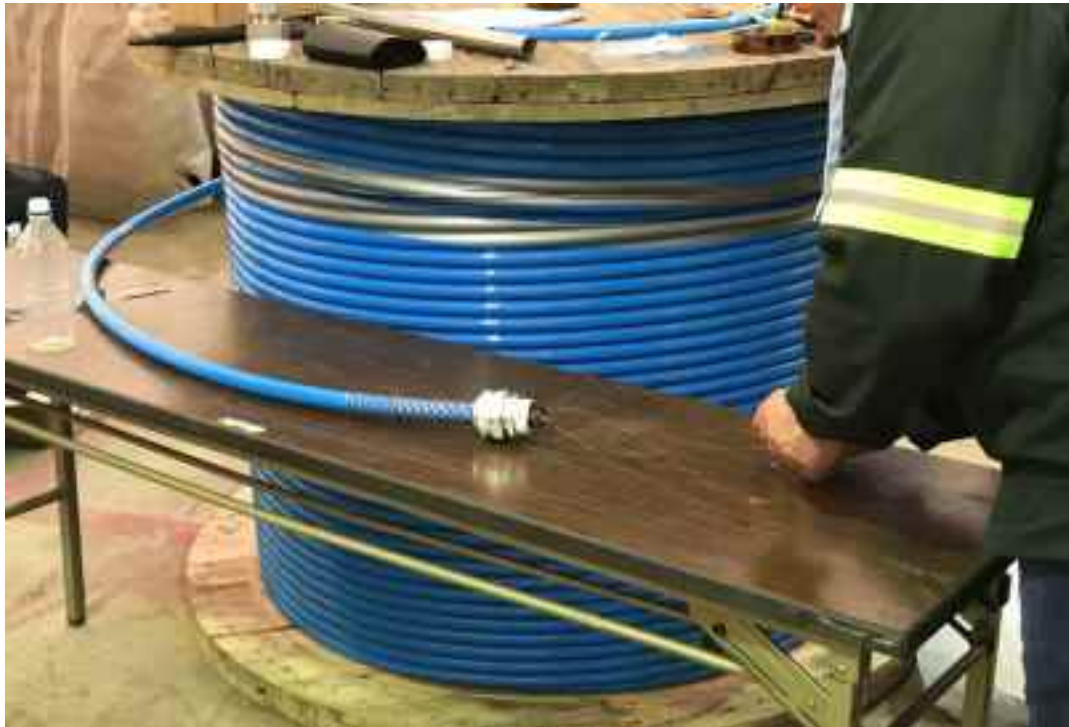
図2.6.1-3 ヘリカル光ファイバーの端末処理作業
