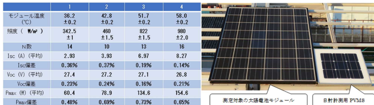
図Ⅲ-2-(ホ)-A-VI-1 (左) JET 電力技術試験所屋上に設置した結晶シリコン系モジュールと PVMS (右) 短絡電流・開放電圧・最大電力の測定再現性精度 (JET 屋上結晶シリコン系モジュール)
