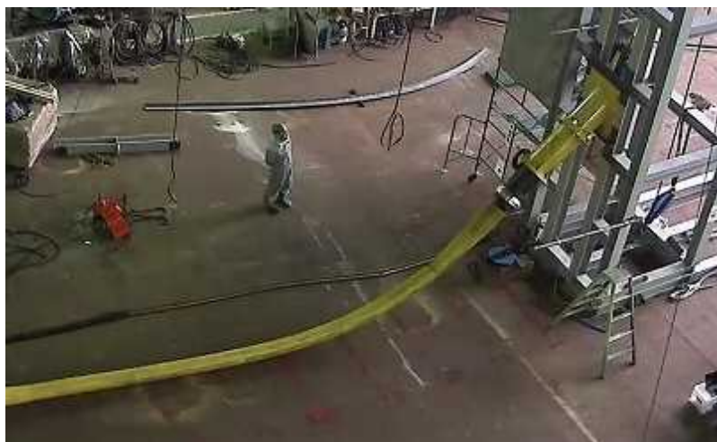
図3-5-19 風車へのケーブル引込作業施工性確認試験状況
