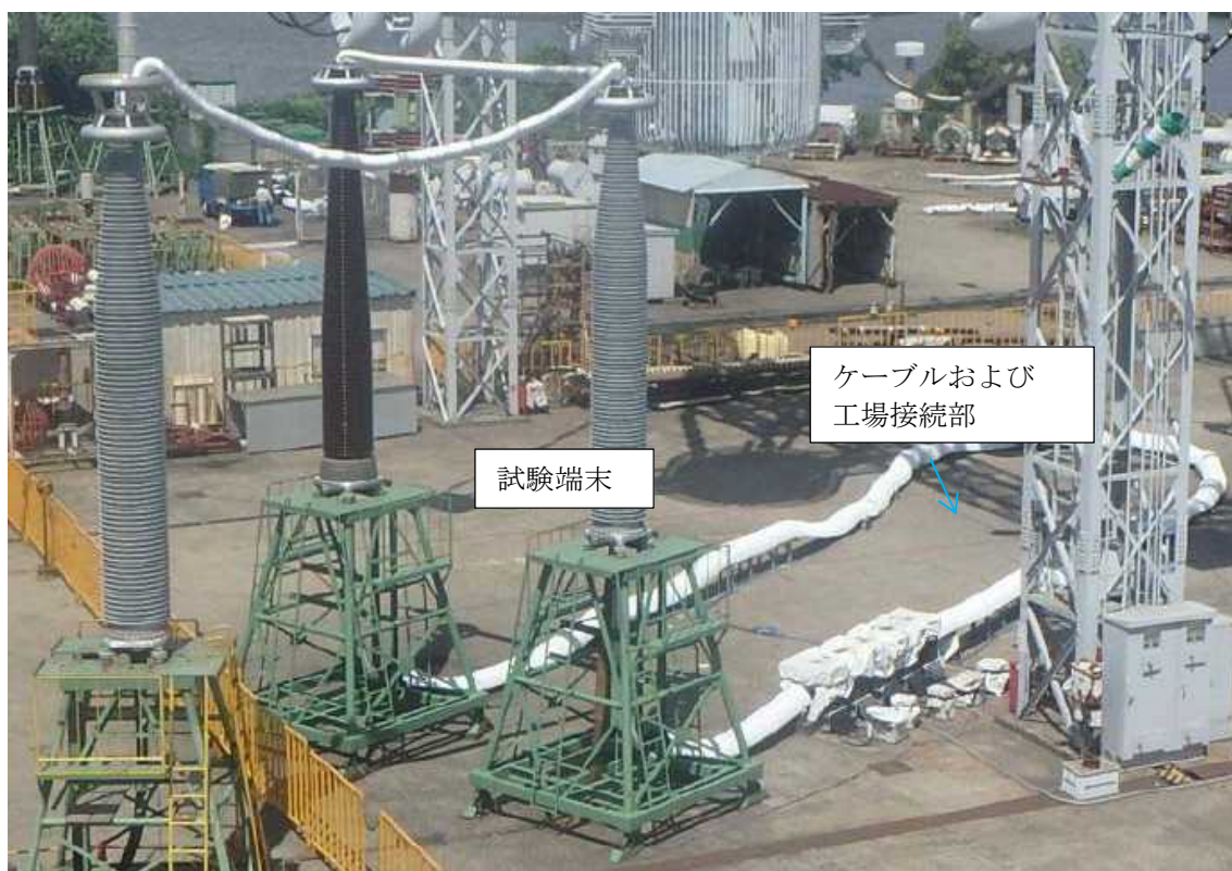
図 3-5-12 異径工場接続部初期評価試験状況
