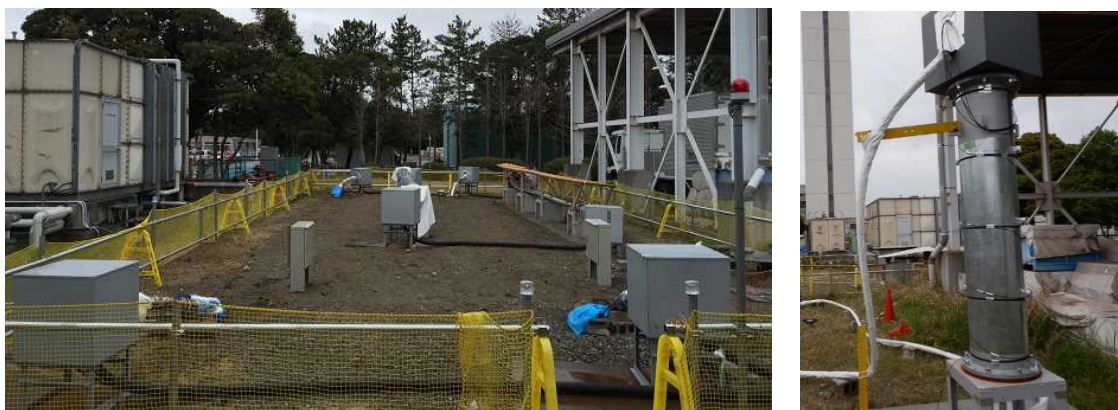
図 3-5-7 ケーブルを布設したフィールド
