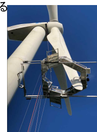
ブレード補修ゴンドラ
