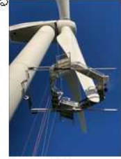
ブレード補修ゴンドラ
