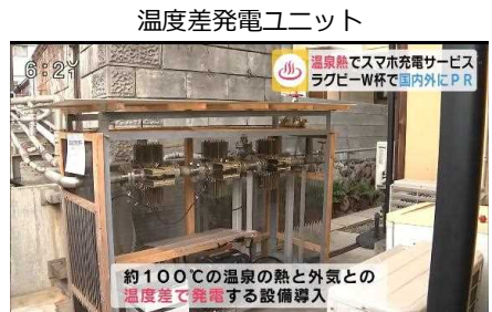
別府地域でのモバイル機器充電, LED照明等を目的とした温度差発電ユニットの設計・製作・評価を継続する。温度差発電による年間20kWh以上の発電が可能であることを実証
