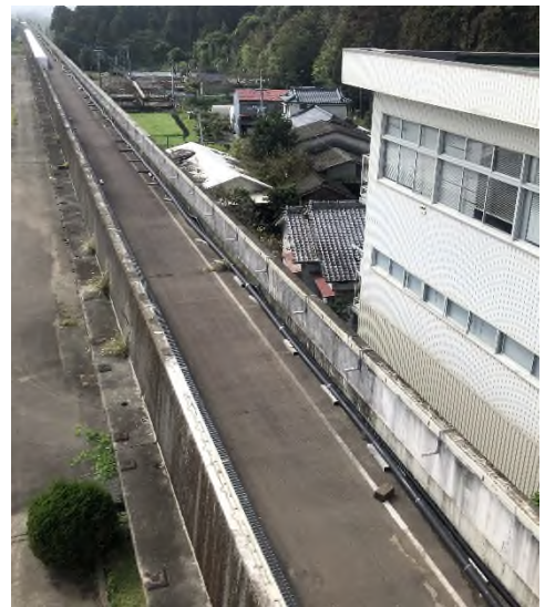
図 2.1.7-7 敷設した断熱管
