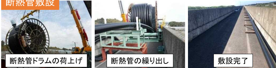
総長1565 mの断熱管を敷設
