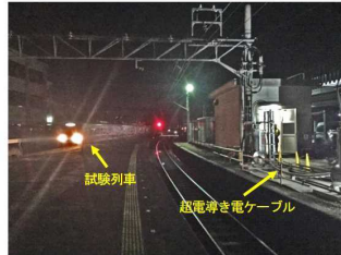
写真2 列車走行試験の様子
