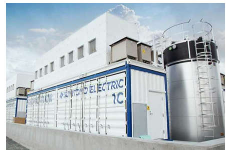
実証事業で導入したレドックスフロー電池
