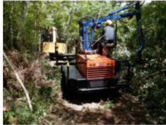
フェラバンチャーが開設し、 フォワーダが支障木を搬出
