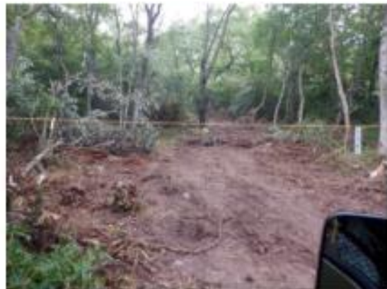
1号線起点の整備状況と 安全のためのロープ設置
