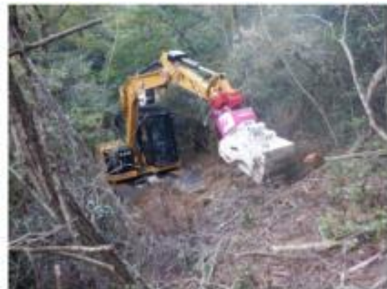
フェラバンチャーによる作業道開設
