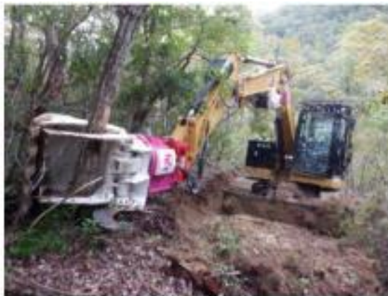
支障木の伐採
