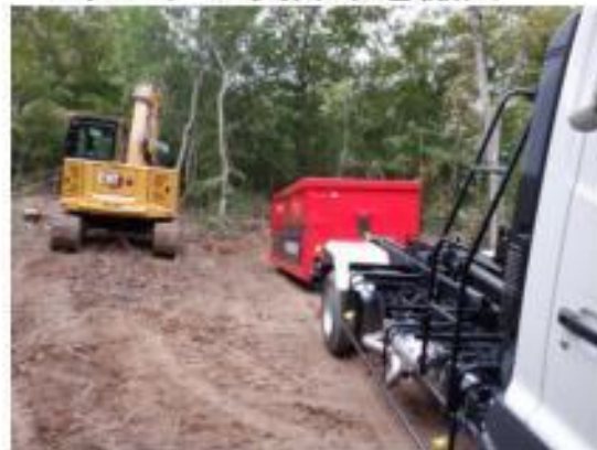
作業スペースにコンテナを仮設置
